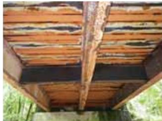
鋼桁・鋼床版の塗装劣化
