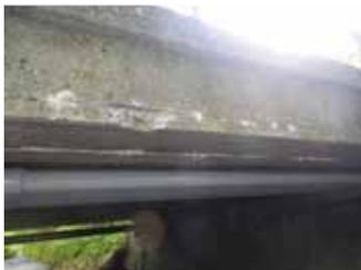
コンクリート桁の鉄筋露出
