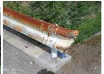
防護柵の変形・ボルト脱落
