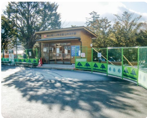
現在の待合所 (撤去前)
