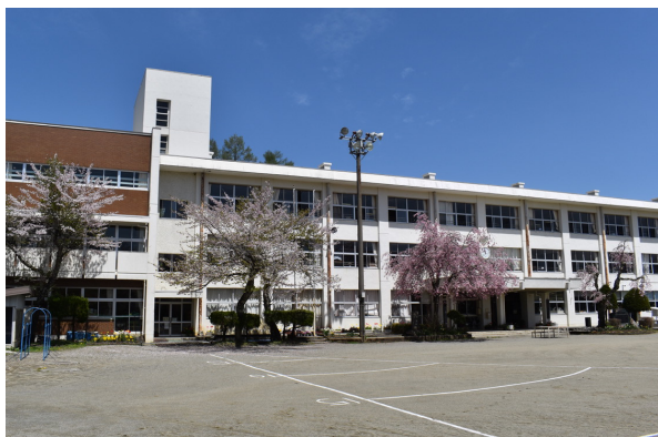
昭和44年建築、 55年が経過した山中小学校
