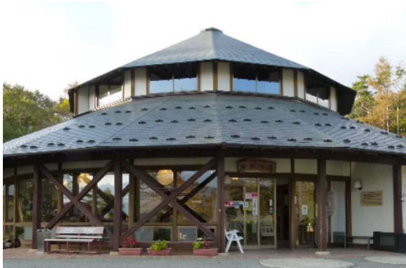
老朽化が進む平成8年オープンの「石割の湯」
