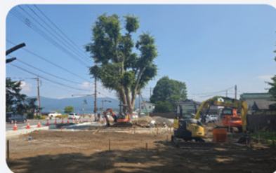
バスロータリー工事
