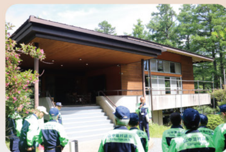
築約70年経過している管理棟
