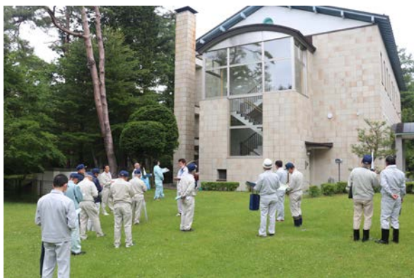
文学の森 修繕箇所確認
