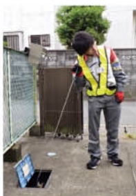
(参考)漏水調査イメージ写真
