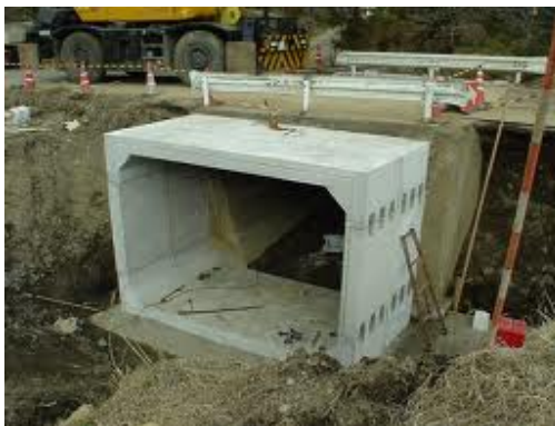
ボックスカルバート施工例
