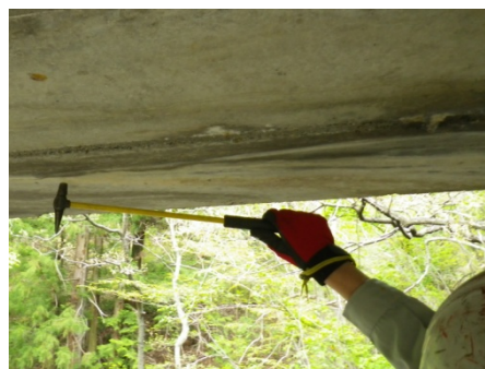
点検実施状況（打音検査）
