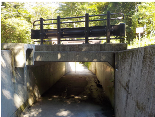
ボックスカルバート施工例（22 無名）
