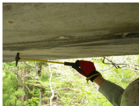
点検実施状況（打音検査）
