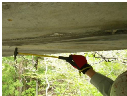
点検実施状況（打音検査）
