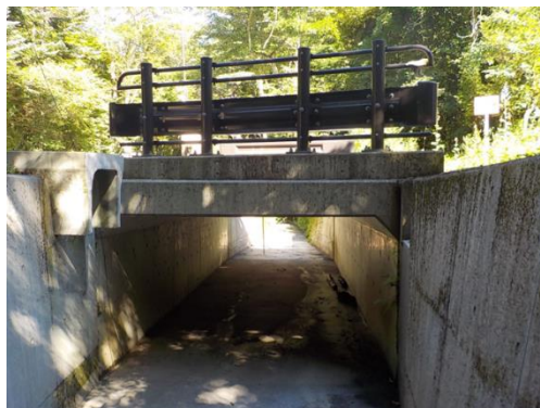
ボックスカルバート施工例（22 無名）
