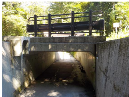
ボックスカルバート施工例（22 無名）
