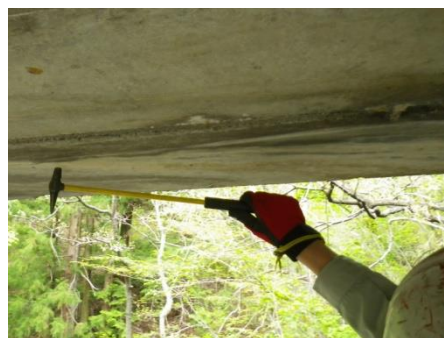
点検実施状況（打音検査）
